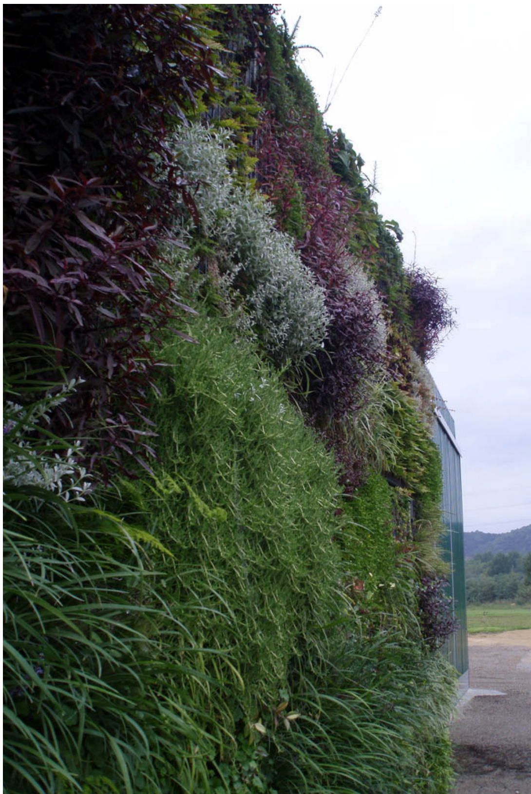
Pared vegetal Babylon® en Vivers Ter para reutilización de aguas grises.
